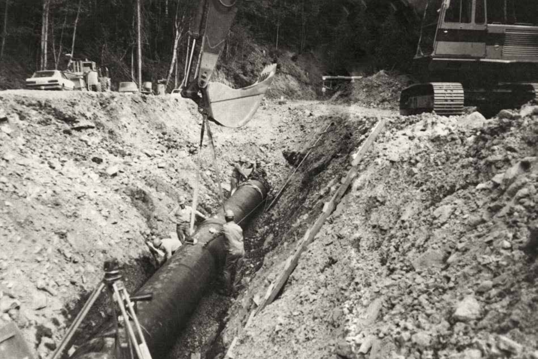
Grøft ved Toverud
