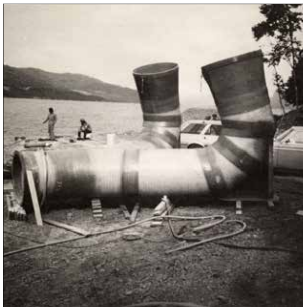
Toverud: Rørene ved vanninntak
